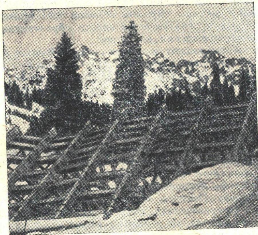
Рис. IV-6. Сквозной селеулавливатель.
